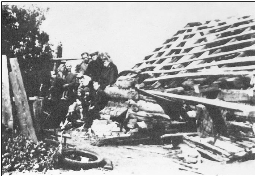
Семья Н. Я. Дейнеги у дома, разрушенного трактором.
